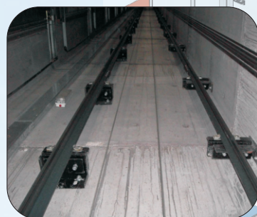
CDM电梯导轨夹隔振
