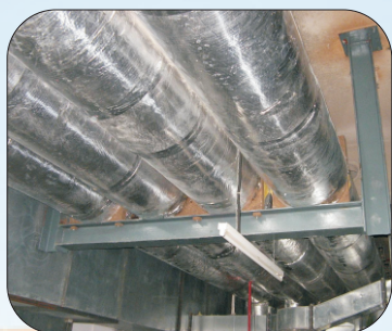
CDM水管隔振系统
